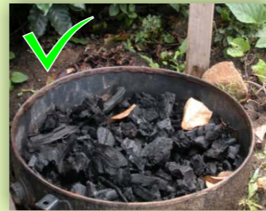
▲ Buang air limbah ke dalam lubang yang berisi arang, kerikil, sabut kelapa, pasir, dll. lalu ditutup agar air hujan tidak masuk
