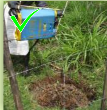
▲ Buang air limbah ke dalam lubang yang berisi arang, kerikil, sabut kelapa, pasir, dll. lalu ditutup agar air hujan tidak masuk
